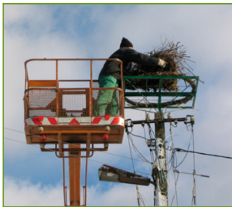
Wkładanie wyściółki na platformę metalową zainstalowaną na słupie energetycznym. Fot. AT
