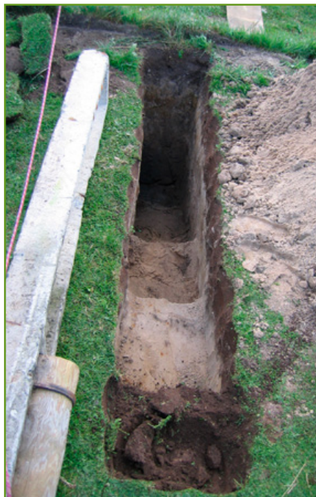
Schodkowy wykop ułatwiający ustawienie słupa. Fot. AT
